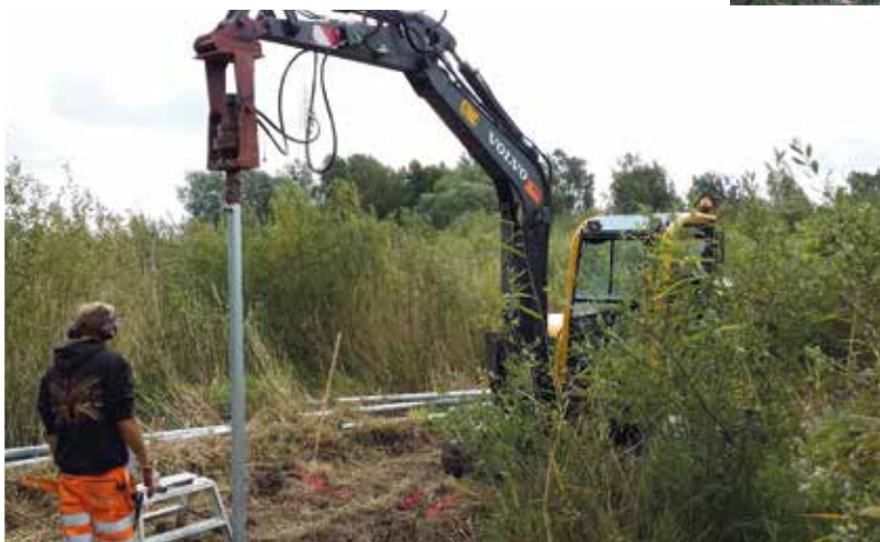
Beperkte schroefapparatuur kan op de moeilijkste locaties worden gebracht.
